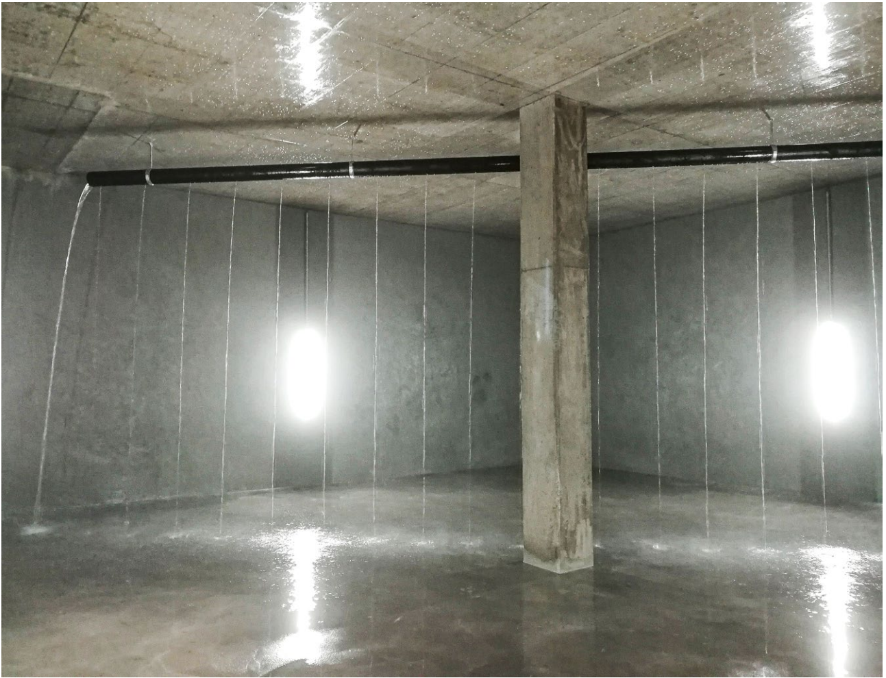
Befüllung des Reservoir Steinbruch, Etzgen.
